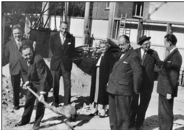
Van links naar rechts: Crols A., burgemeester H. Bauweraerts met spade, F. Peeters, mevr. Dergent- Bouvin, L. Peeters, aannemer K. Vanhout en R. Proost. Foto: lieve Hoppenbrouwers- Peeters
