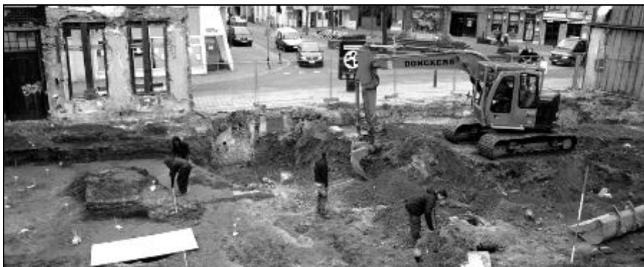
Opgravingen aan het Zegeplein (foto Adak)
