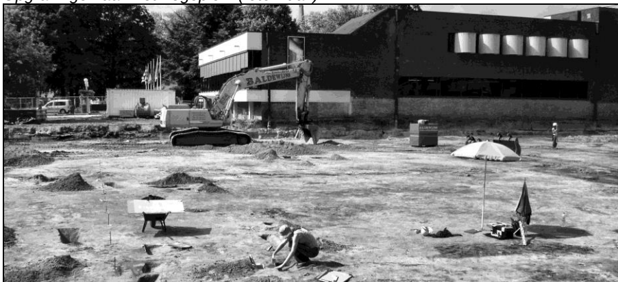
Opgravingen aan de Warandeparking
