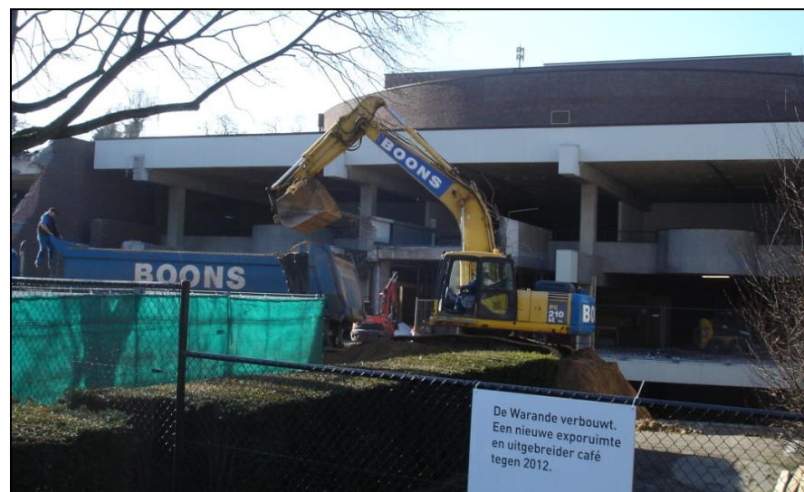
Huidige grondige renovatie- en aanpassingswerken aan de Warande
