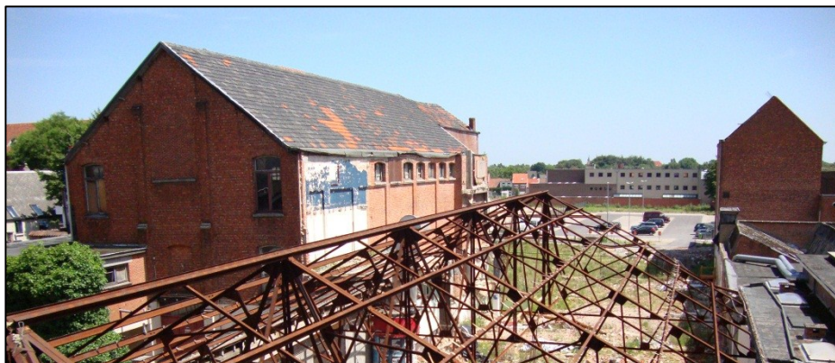
De feestzaal staat links op de foto (vooraan het dakgebinte van het ontmantelde zwembad Kursaal)
