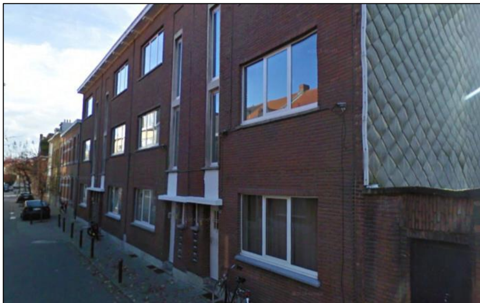
Het appartementsgebouw in de Vredestraat waartegen de gedenksteen werd aangebracht.
