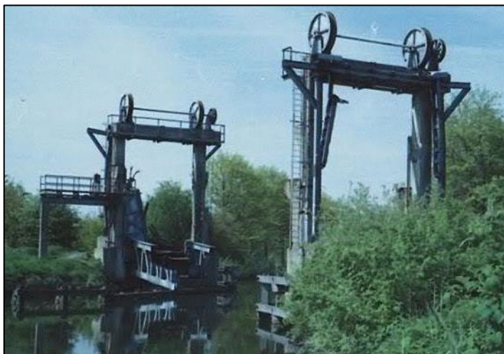
Foto van de half ontmantelde spoorwegbrug over de Vaart, jaren 1970.
