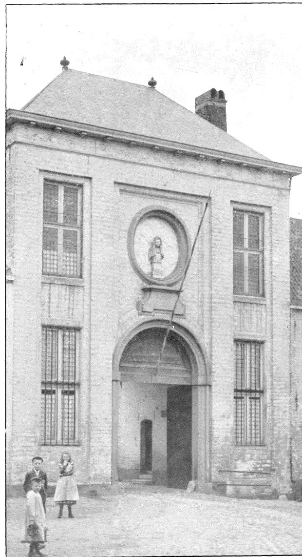
Ingangpoort van het Begijnhof te Turnhout.
